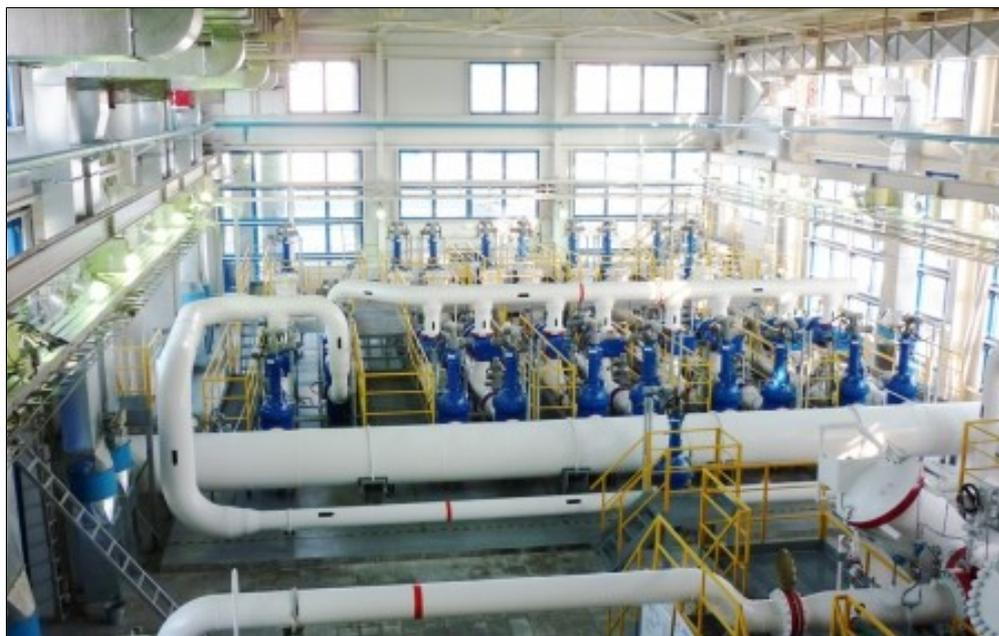
СИКН и СИКГ предназначены для ведения коммерческого или оперативного (технологического) учета получаемой или отпускаемой продукции.
